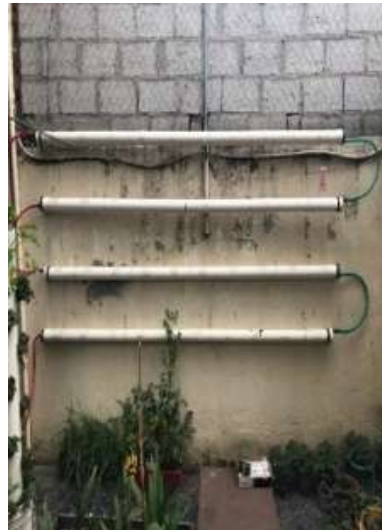
Figura 1. Instalación del sistema Fuente: Autor
