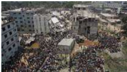
Figura 3. Destrucción de un edificio debido a las pésimas condiciones del mismo, donde fallecieron 300 personas en el año 2013 Fuente: [10]
