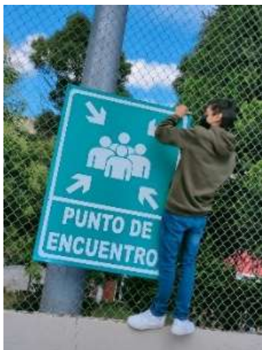
Figura 5. Colocación del letrero
