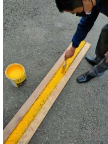
Figura 8. Pintado de las líneas del parqueadero Fuente: Autores
