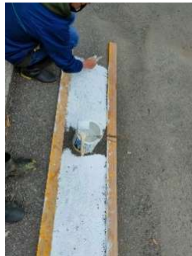
Figura 9. Pintado del paso cebra Fuente: Autores
