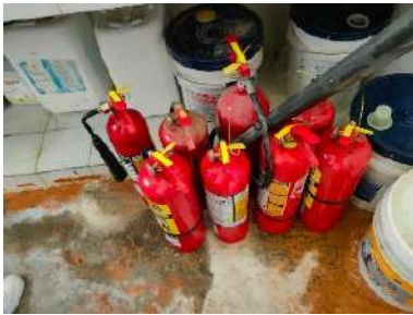
Figura 7. Extintores embodegados Fuente: Autores
